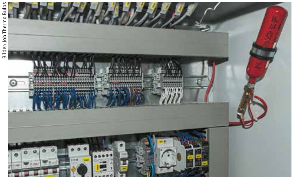
Miniaturl-Feuerlöschereinheit: Für einen Schaltschrank reicht die Löschampulle nicht aus. Die AMFE arbeitet nach dem selben Prinzip wie ein Sprinkler.
